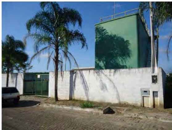
(a) Entrada ETE Solar Bitti
