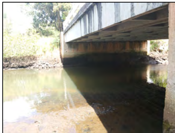
Figura 9.8.6.8-9: Ponte localizada na entrada ao sul de Santa Rosa pela Rod. ES-261. Fonte: Foto própria.
