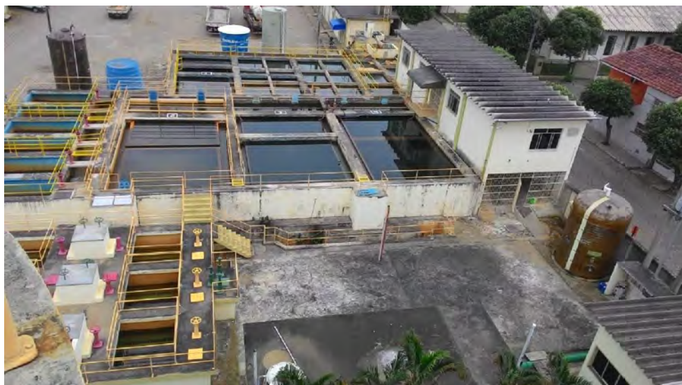
Figura 6.1.1-2: Estação de tratamento de água para o subsistema Aracruz-Sede.
