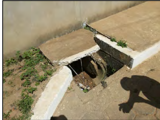
Figura 9.8.6.8-4: Bueiro com drenagem insuficiente na saída norte de Santa Rosa.
