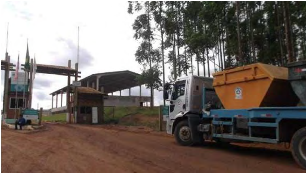
Figura 8.5.1.1-1: Acesso à Central de Tratamento de Resíduos.
