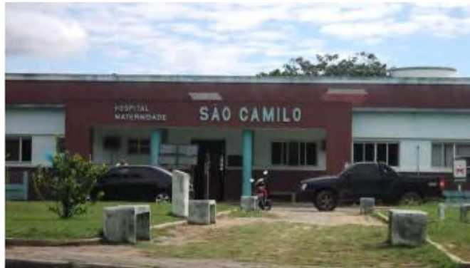
Figura 8.3.2-1: Unidade de Grande Gerador dos RSS (Hospital São Camilo).
