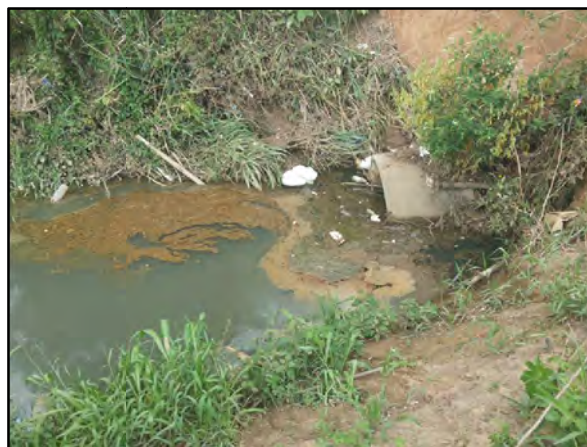
Figura 9.8.1.1-8: Canalização do Córrego Guaxindiba em manilha na travessia sob a Rua 1º de maio. Fonte: Foto própria.
