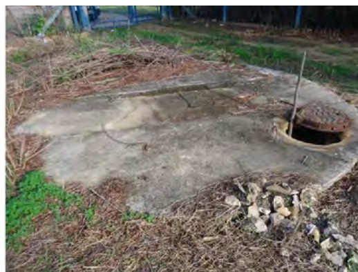
(b) Biofiltro anaeróbio
