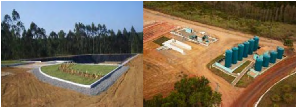
Figura 8.5.1.1-8: Lagoas e Tanques de Armazenamento de Efluentes.
