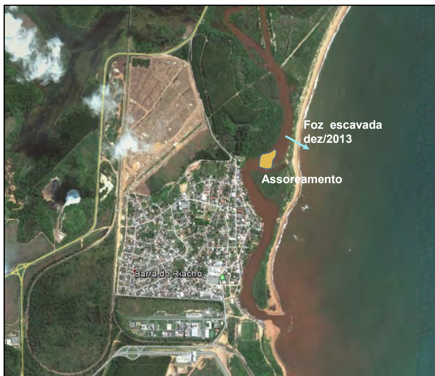
Figura 9.4-11: Foz escavada em situação de emergência (seta azul) e assoreamento no Rio Riacho (em amarelo). Fonte: Demarcação em Google Earth.
