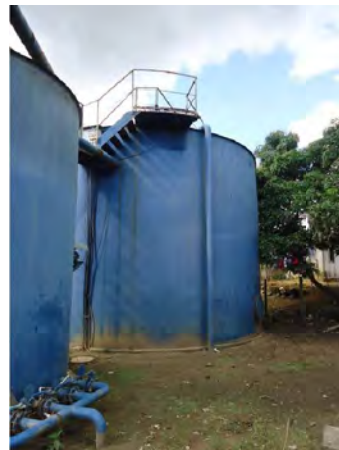
(d) Reator anaeróbio
