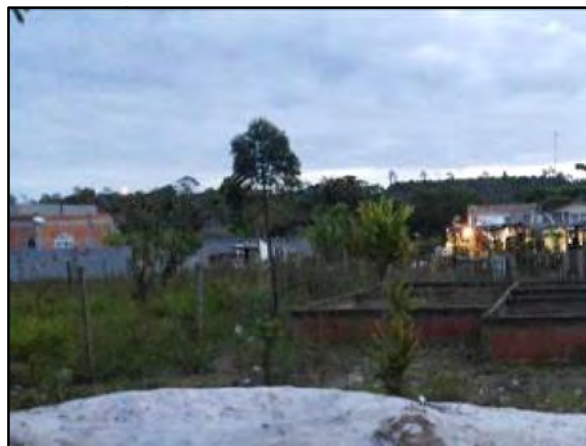
Figura 9.8.6.7-8: Passagem de água por baixo da ES-010 (a) e a passagem alternativa no bairro Rio Preto que liga os municípios de Aracruz e Fundão (b). Fonte: Fotos próprias.
