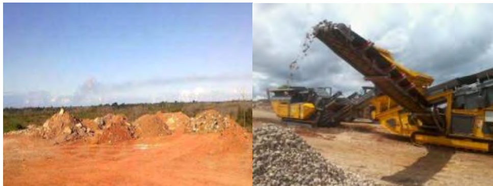
Figura 8.5.1.1-6: Aterro de Inertes e Triturador de Resíduos.
