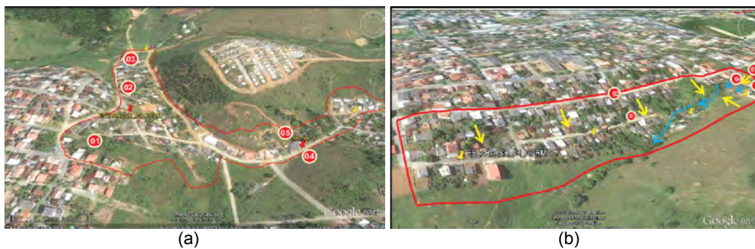
Figura 9.9-4: Setores de risco de deslizamento do Bairro Santa Limão (a) e São Camilo (b). Fonte: CPRM (2012).
