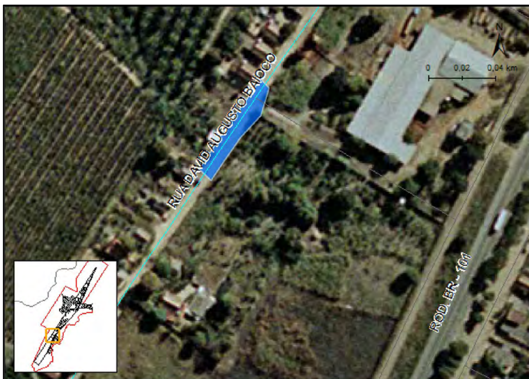
Figura 9.8.2-9: Área sensível (em azul) a alagamento na Rua David Augusto Baioco (373884 S, 7832560 E). Fonte: Adaptado de IEMA.
