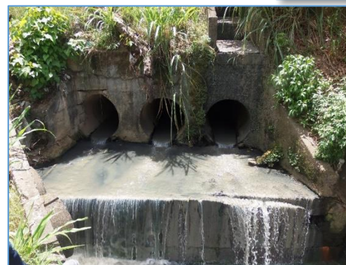
INÍCIO DA CANALIZAÇÃO EXPOSTA DO CÓRREGO MOROBÁ
