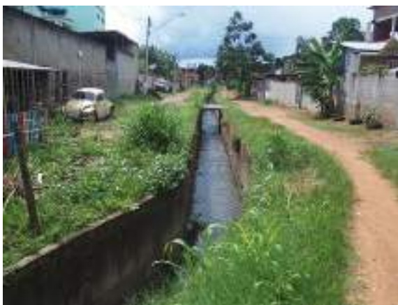
Figura 23 - Trecho urbano do córrego Morobá com as margens de concreto armado.
