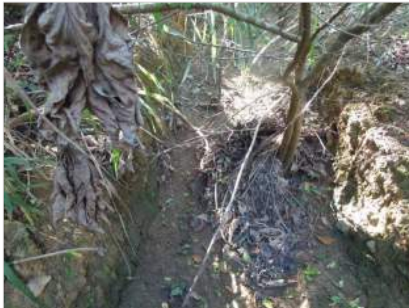
Figura 27 - Trecho de drenagem com formato regular, apresentando indícios de implantação antrópica.
