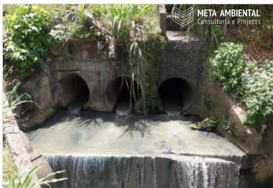
Figura 32 – Início da canalização exposta do Córrego Morobá.
