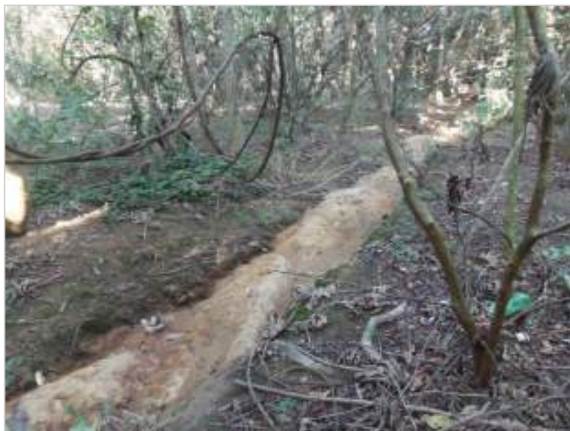
Figura 24 - Trecho de drenagem sem volume de água.
