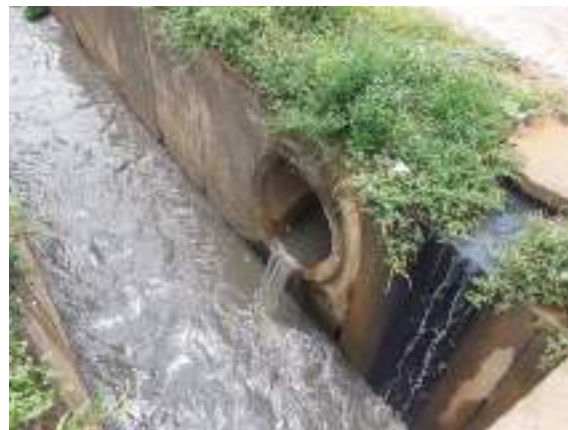
Figura 26 - Drenagem urbana destinada ao córrego Morobá.
