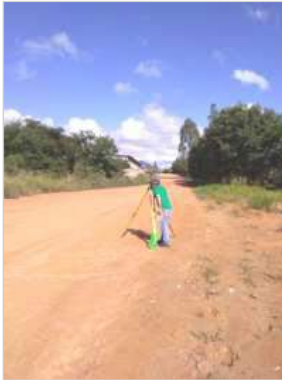
Figura 41 - Nivelamento da área interna do Centro Empresarial com Nível WILD NA2.
