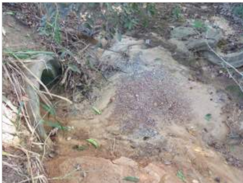
Figura 28 - Manilha localizada próxima das coordenadas 367067 E / 7805319 N.
