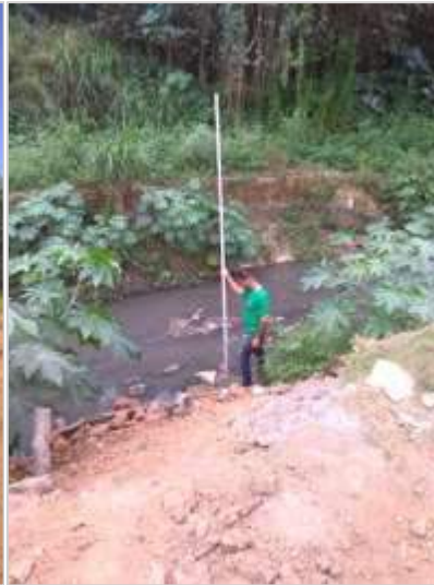
Figura 42 - Nivelamento da lâmina d'água do Córrego (Canal) Morobá.
