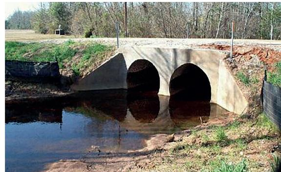
Figura 7: Estrutura de dissipação de energia que deverão ser utilizadas em taludes ou pontos de lançamento da drenagem e estrutura para travessia de cursos hídricos e áreas alagadiças.
