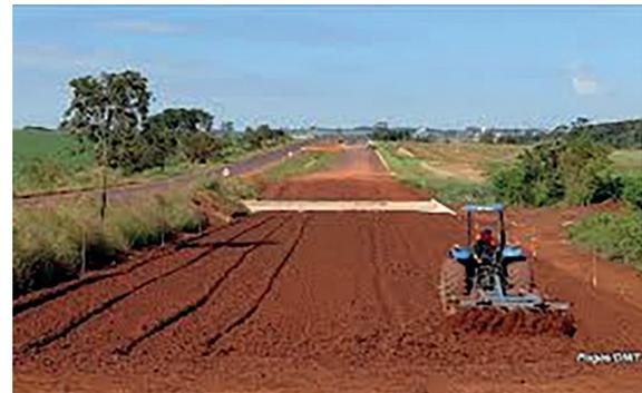
Figura 9: Homogeneização com trator de grades.
