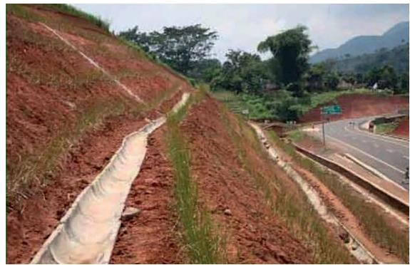
Figura 6: Sarjeta e boca de lobo. Estruturas de drenagem projetadas para a rodovia e modelo de drenagem para taludes.
