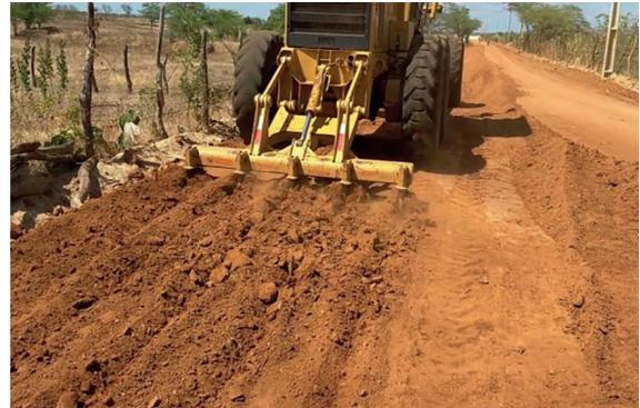
Figura 8: Escarificação com o uso de motoniveladeira.
