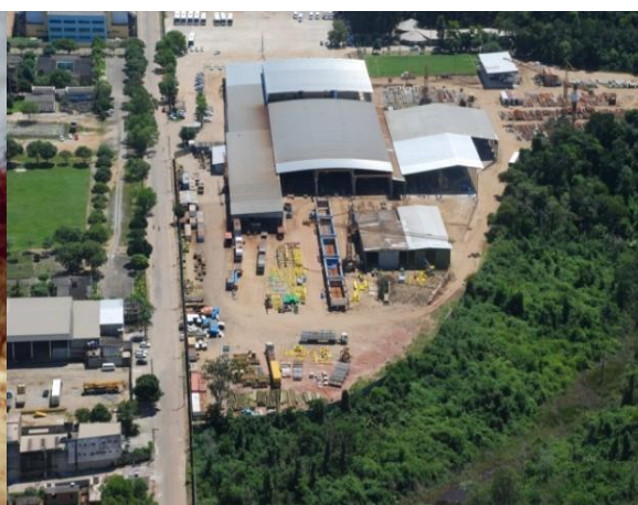
Figura I-2: Instalação em Aracruz em 2012.
