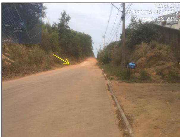
Figura IV-8: Final da pavimentação, sinalizado pela seta amarela.
