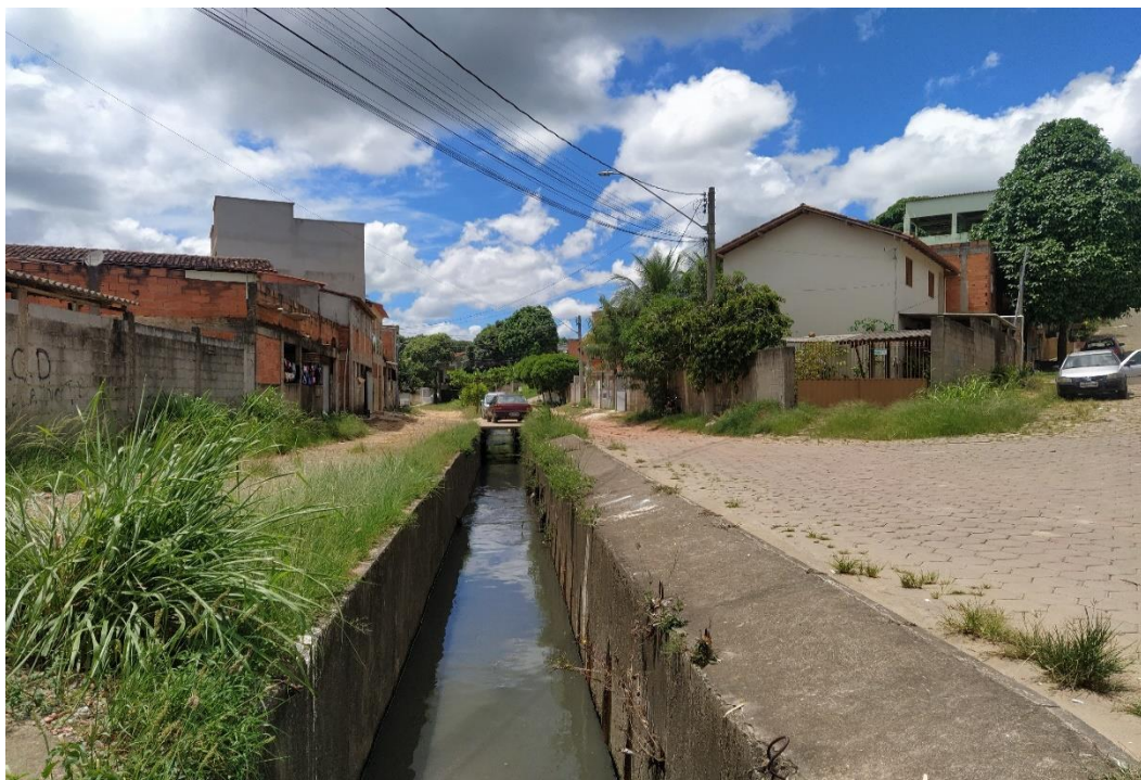
Figura 47: Retificação do Córrego Morobá, Bairro de Fátima 2.
