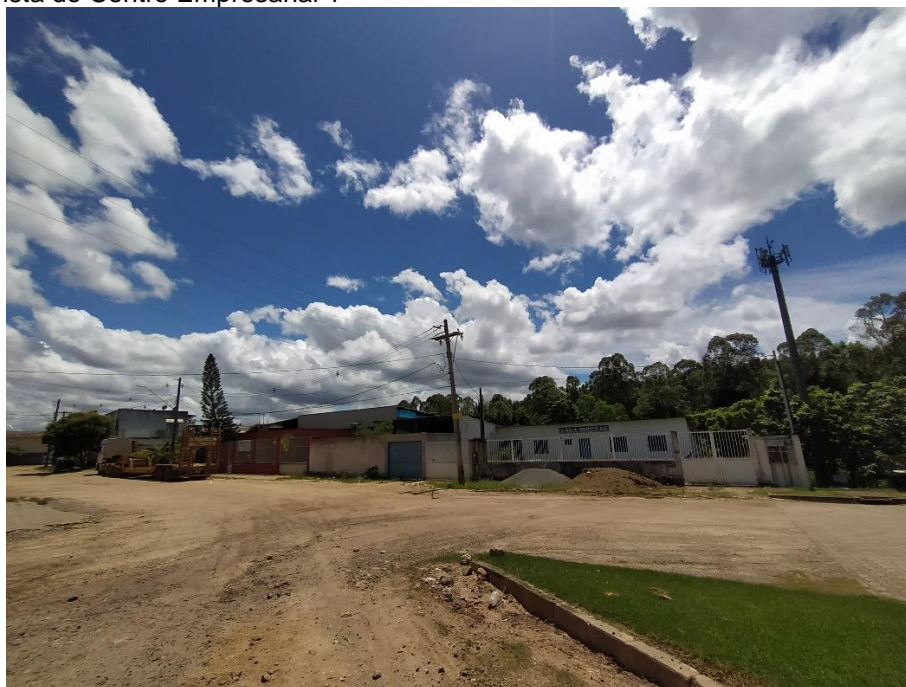
Figura 41: Vista do Centro Empresarial 1
