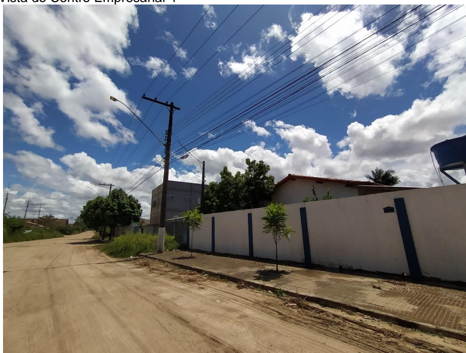
Figura 44: Vista do Centro Empresarial 4
