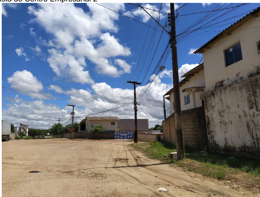
Figura 42: Vista do Centro Empresarial 2
