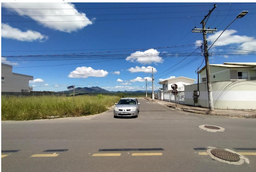
Figura 80: Cena 03 - Após implantação. Vista da Rua Vinte em direção ao empreendimento, próximo a Litig Alimentos.
