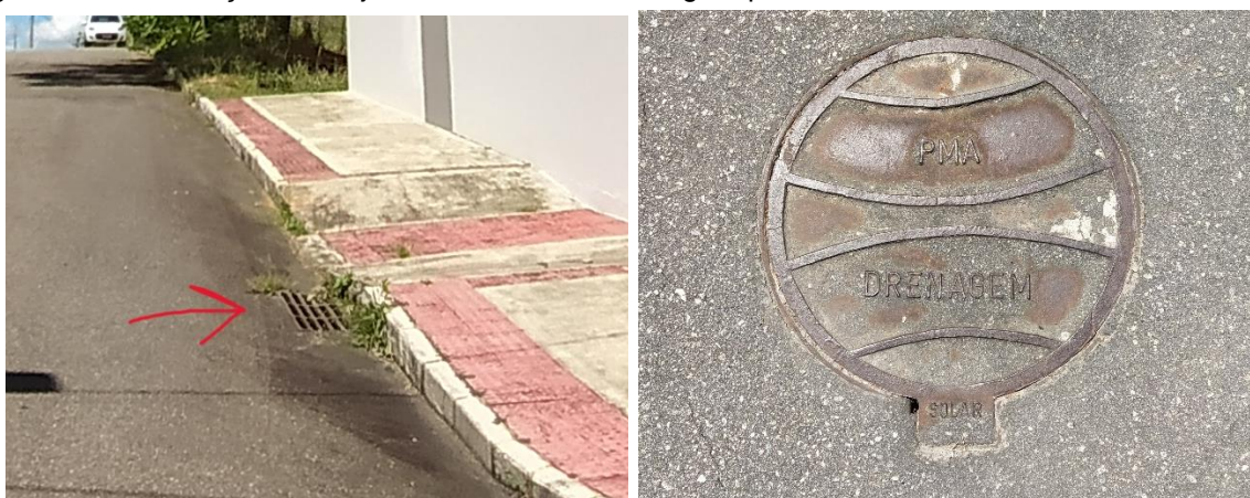
Figura 40: Identificação de sarjetas e sistema de drenagem pluvial.
