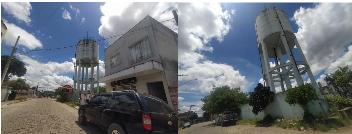
Figura 39: Reservatório Bela Vista.
