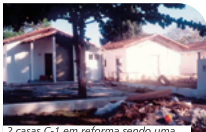
2 casas C-1 em reforma sendo uma com alteração da frente original
