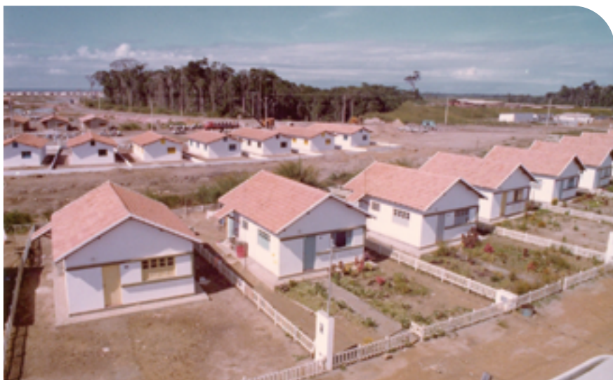
Início da construção do bairro Coqueiral de Aracruz - Rua Jatobás-Arquivo Cedoc Fibria
