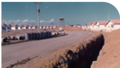
Construção da Rua Jatobás - primeiras casas - Cedoc Fibria
