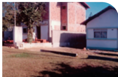
Casa tipo D - construção de 2º piso
