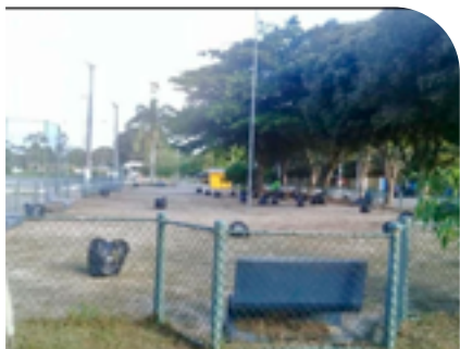
Parquinho em construção - Tião
