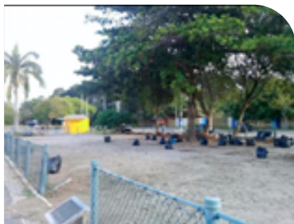
Parquinho sendo construído - Tião
