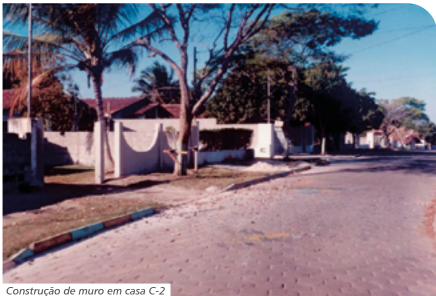
Construção de muro em casa C-2
