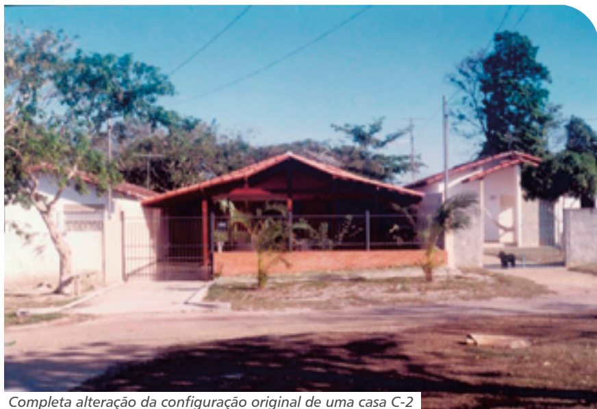
Completa alteração da configuração original de uma casa C-2
