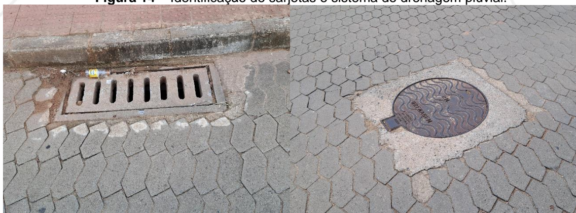
Figura 14 – Identificação de sarjetas e sistema de drenagem pluvial.
