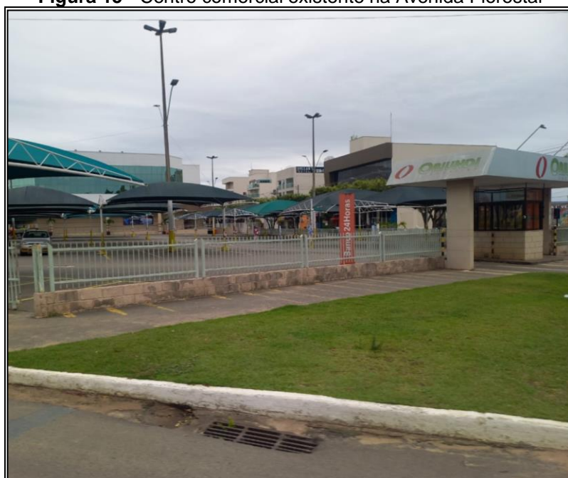
Figura 15 - Centro comercial existente na Avenida Florestal
