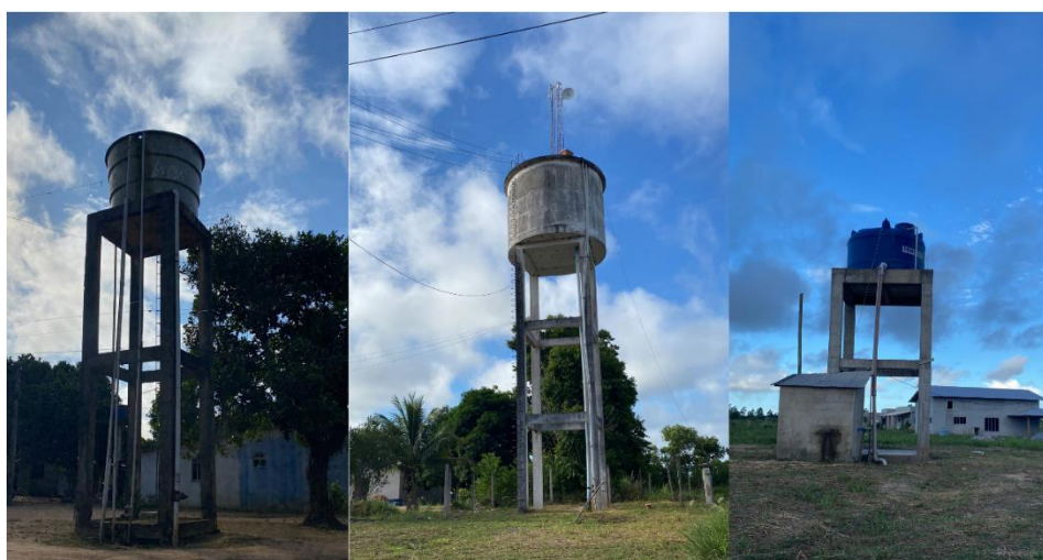
Figura 6-3: Reservatórios de água, Aldeia Pau Brasil.
