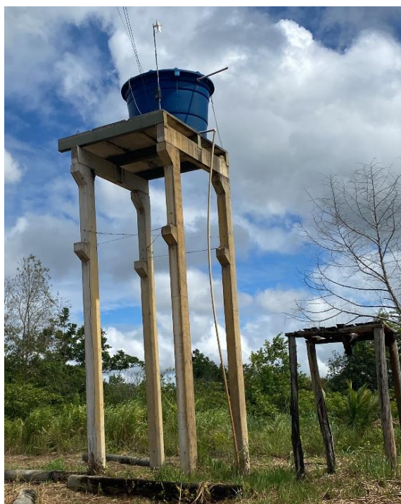
Figura 6-4: Reservatório, Aldeia Amarelos.
