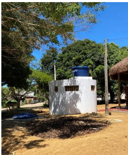
Figura 7-3: Banheiro com fossa, Aldeia Irajá.
