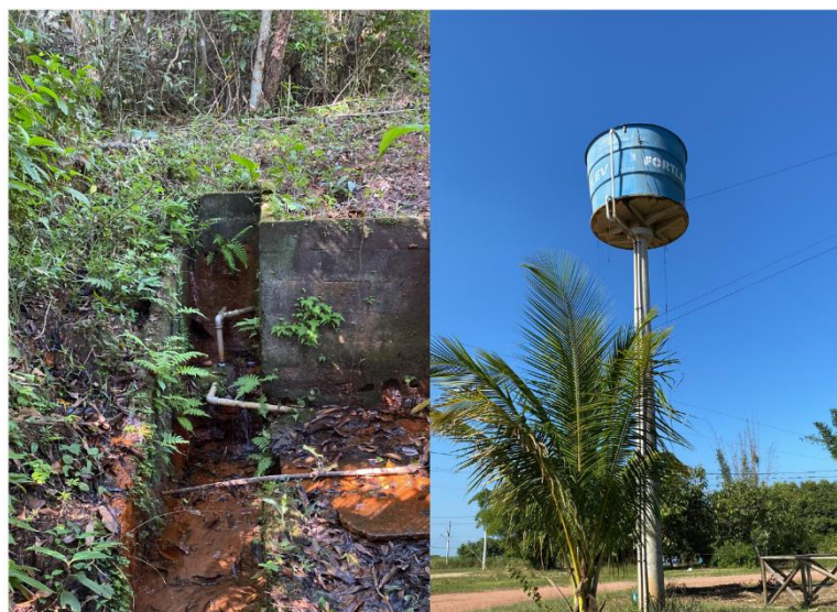
Figura 6-5: Nascente Olho D'água e reservatório, Aldeia Olho D'água.
