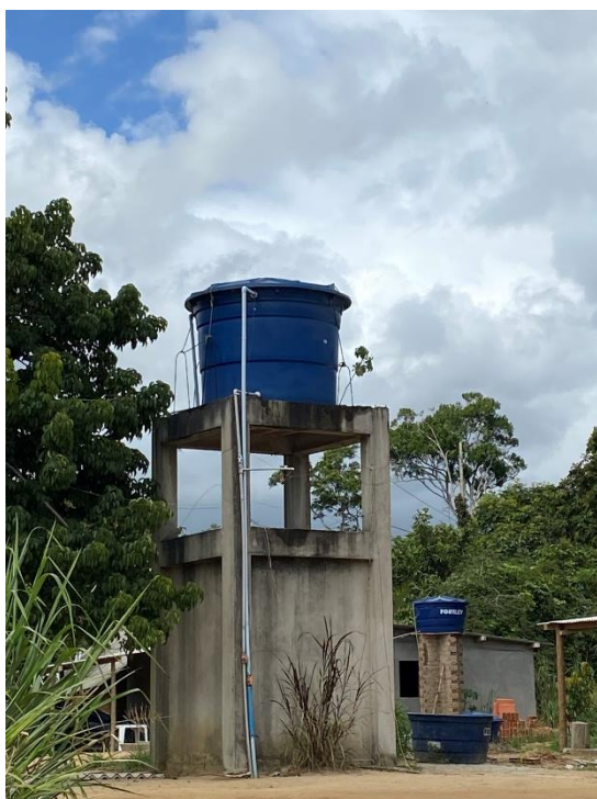
Figura 6-6: Reservatório, Aldeia Nova Esperança.
