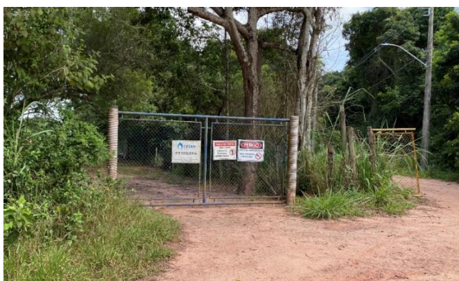
Figura 7-1: Entrada da ETE Coqueiral, Aldeia Piraquê-Açu.
