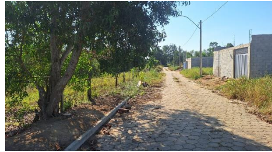
Imagem 58: Vias pavimentadas na área de influência direta, mostrando também edificações no local. Fonte: Arquivo pessoal, 2024.
