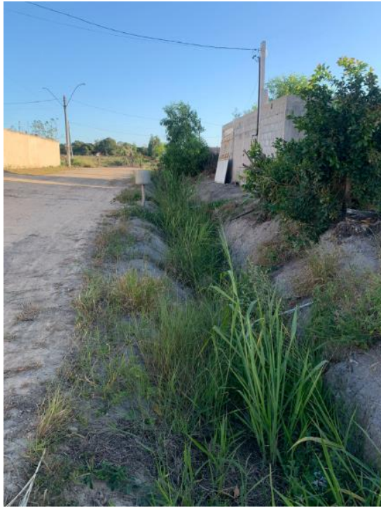
Imagem 44: Rua Buenos Aires, valas erosivas. Fonte: Arquivo pessoal, 2024.
