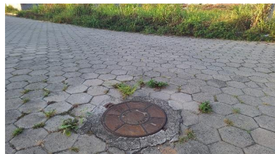
Imagem 56: Evidências da rede de coleta de esgoto na AID.
