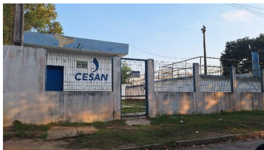
Imagem 55: Estação de Tratamento de Água localizada na AID.
