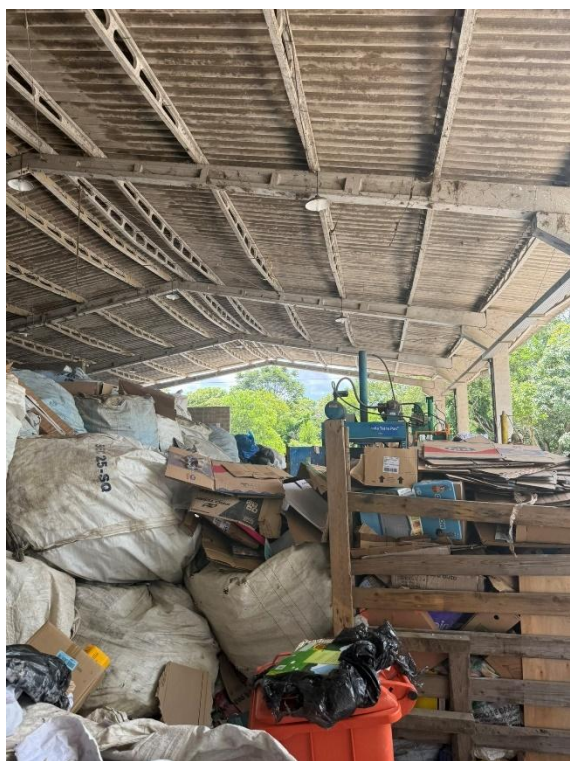
Figura 90 – Galpão de Triagem
