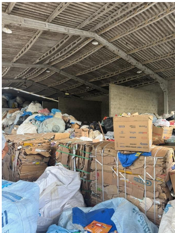
Figura 92 – Galpão de Triagem
