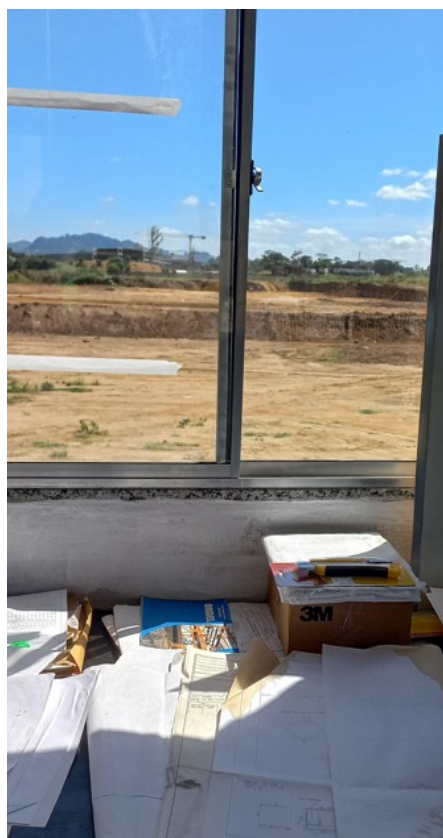
Implantação da Usina Fotovoltaica
