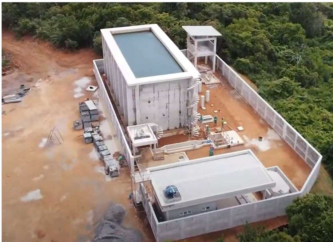
Figura 24: ETE de Barra do Sahy em sua fase de construção.
