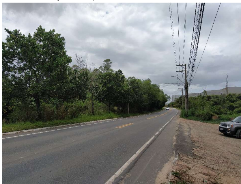
Figura 47: Cena 01 - Atual. Vista do início do Bairro Santa Marta para ES-010 em direção ao empreendimento.
