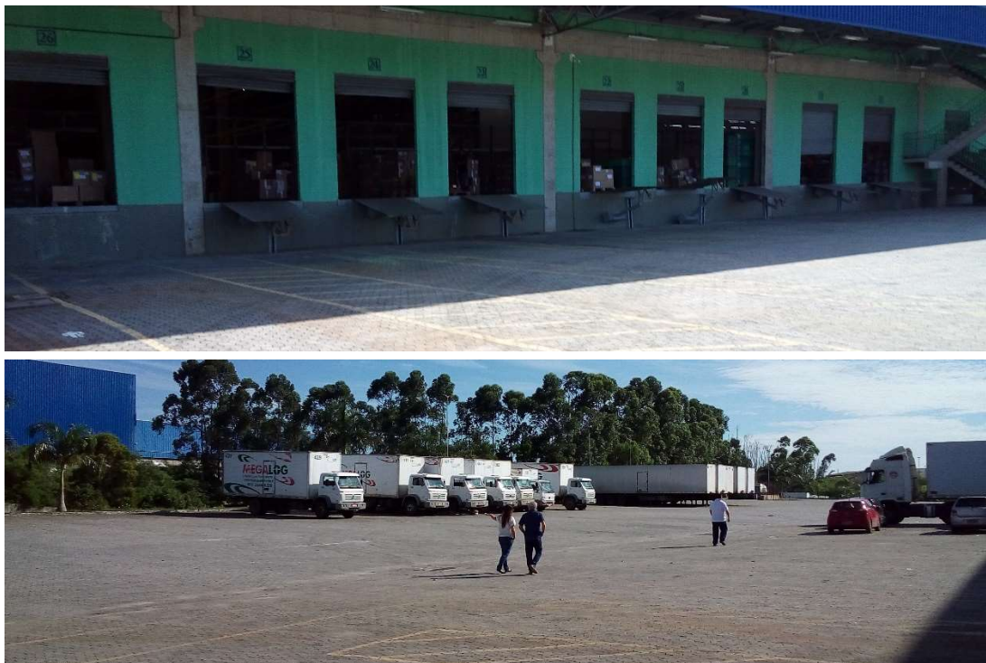
Figura 9: Docas e pátio interno - estacionamento de caminhões
