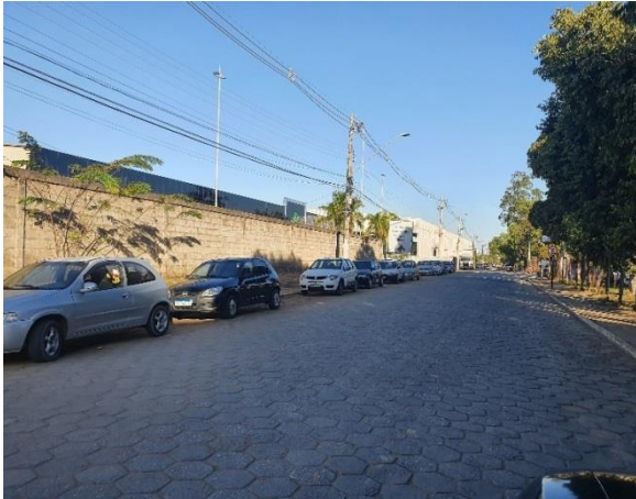
Figura 6-2: Ponto 1: Vista da Rodovia Demócrito Moreira sentido oposto à rotatória com a BR-257.
