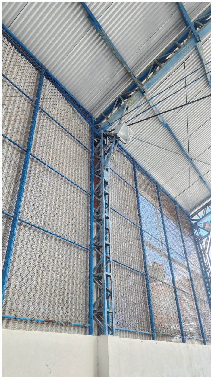
Figura 5 - Treliças com camada de pintura deteriorada.
