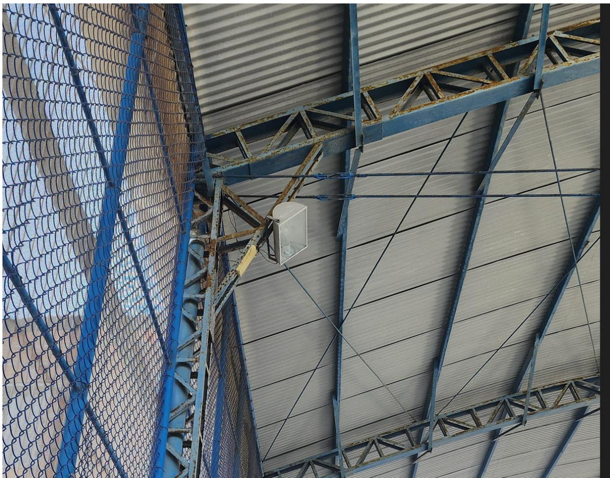
Figura 2 - Treliças com camada de pintura deteriorada.
