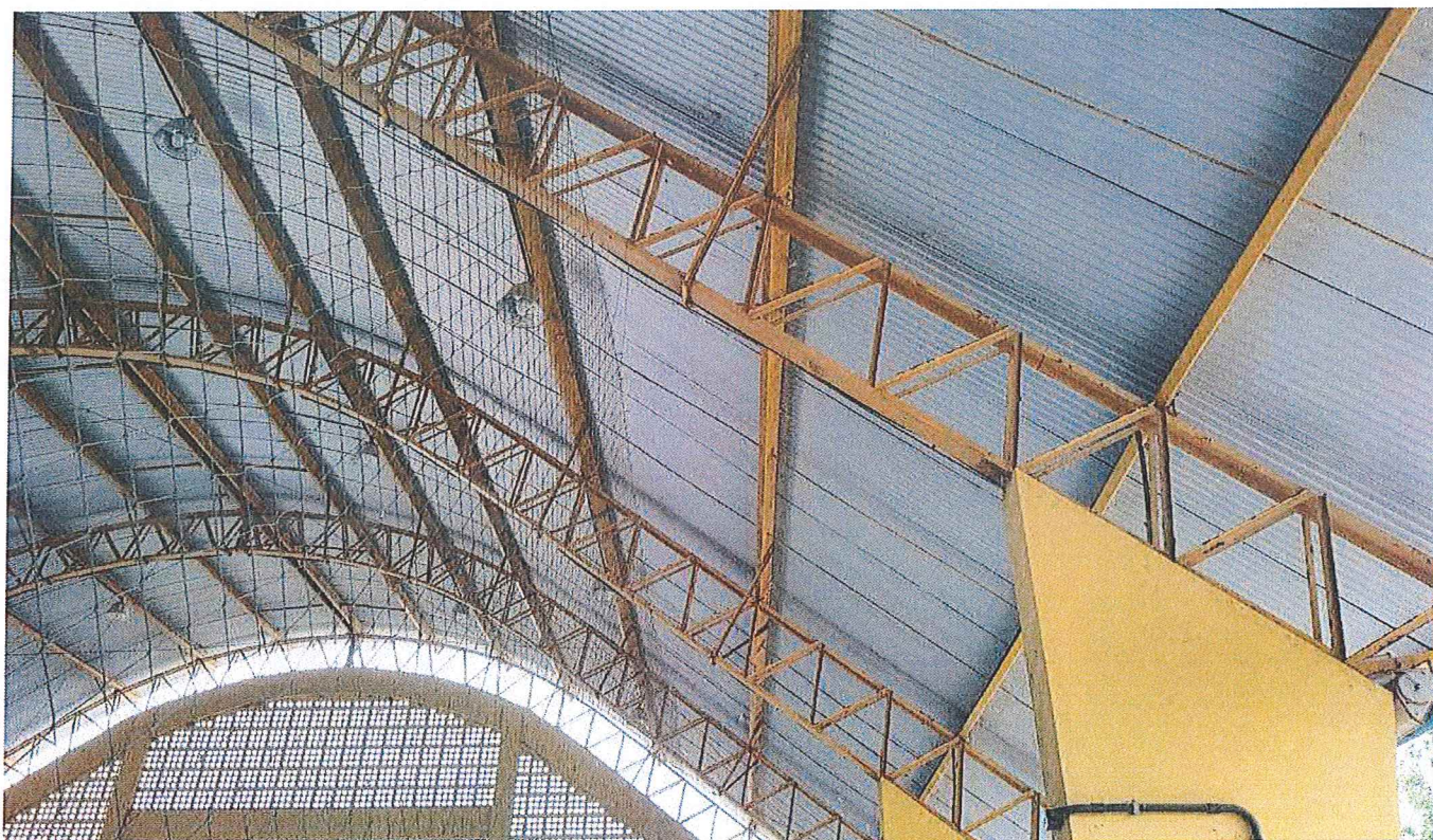
Figura 6 - Terças com camada de pintura deteriorada.
