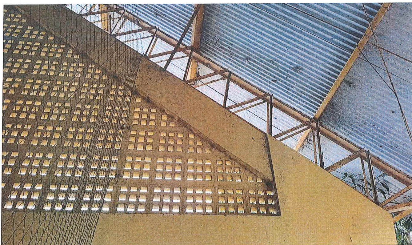
Figura 2 - Treliça com camada de pintura deteriorada.
