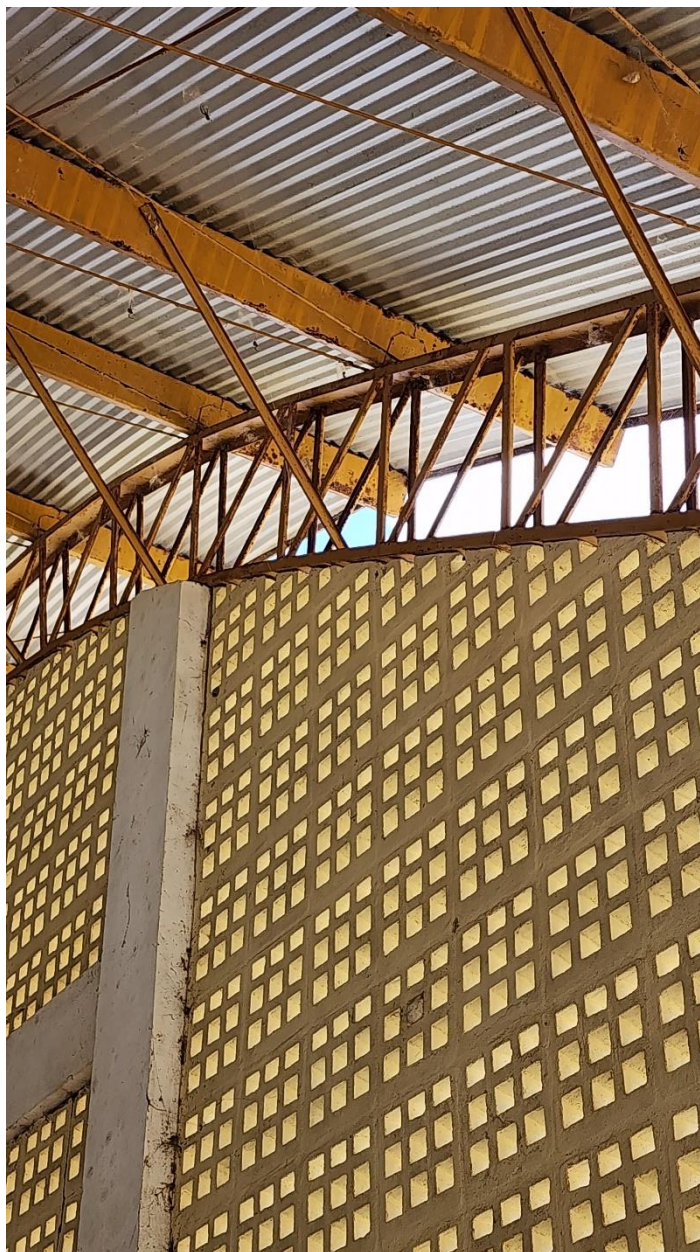
Figura 3 - Terças com camada de pintura deteriorada.
