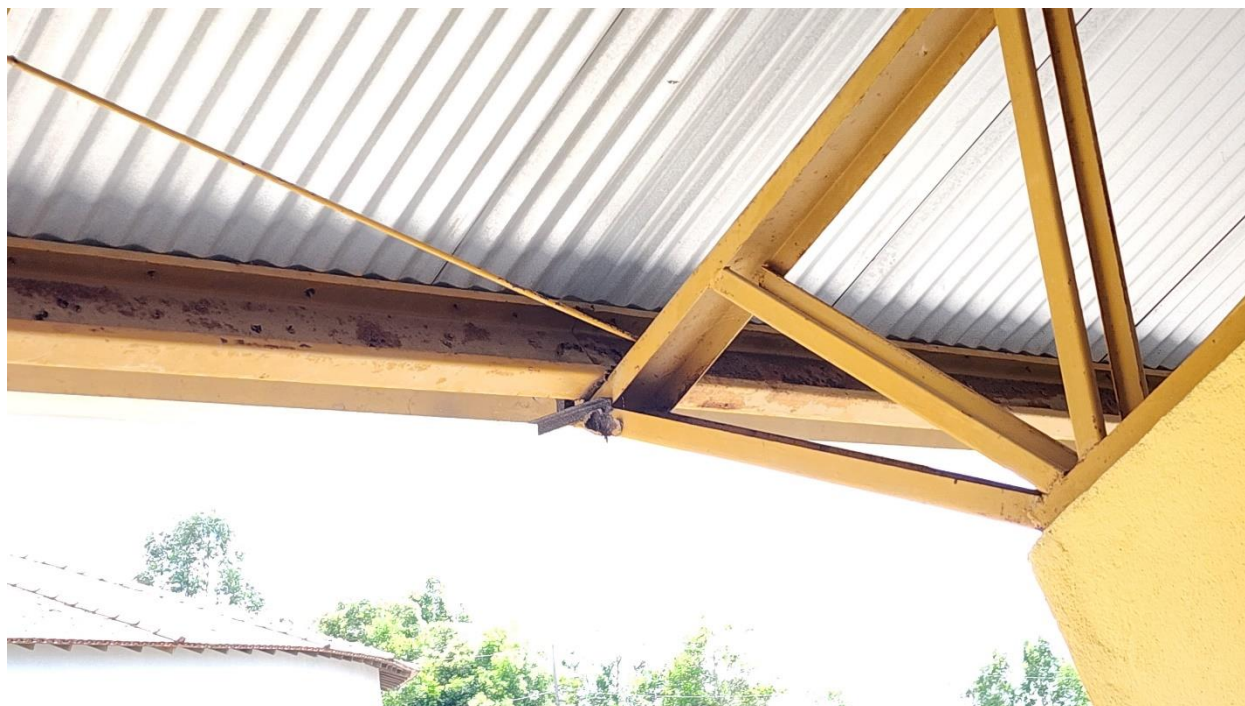
Figura 5 - Treliça em boas condições de pintura e terça com perda da camada de pintura na alma.
