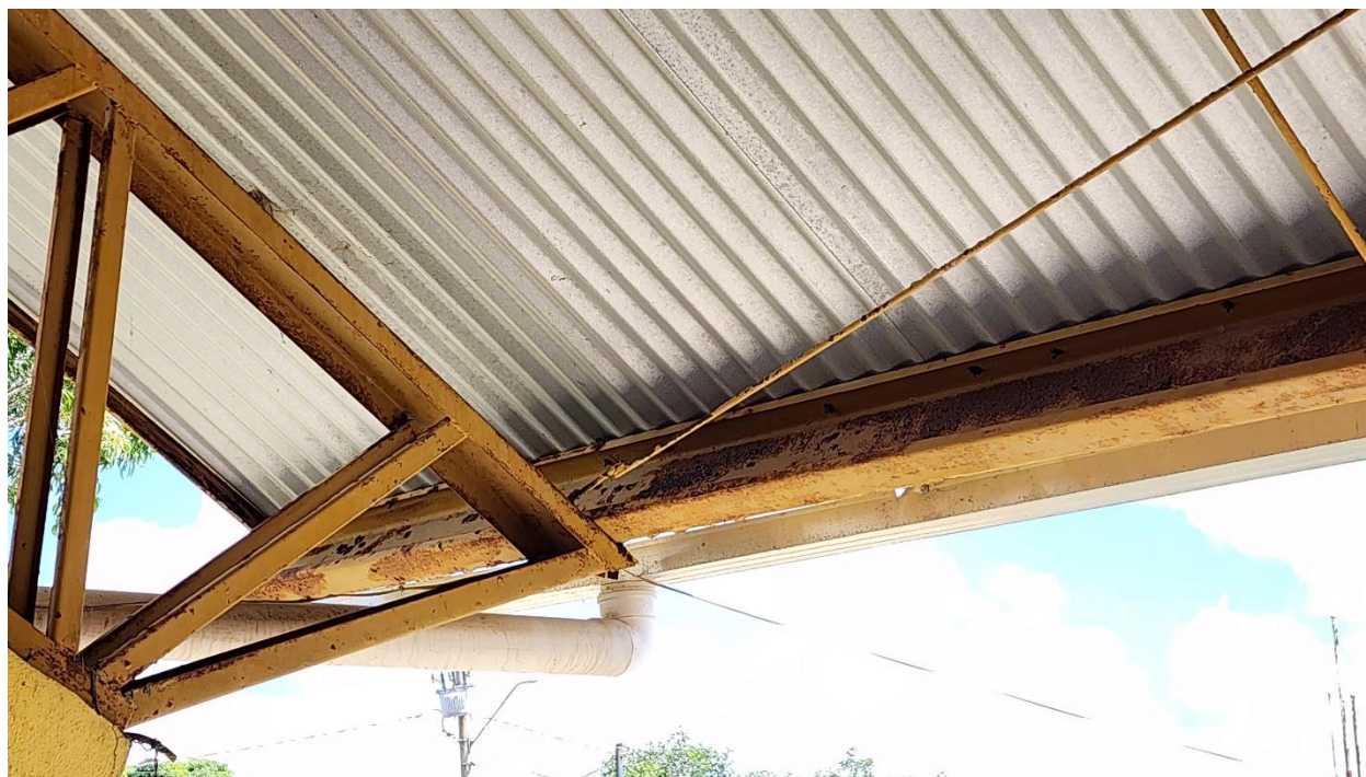
Figura 6 - Terça com camada de pintura deteriorada.
