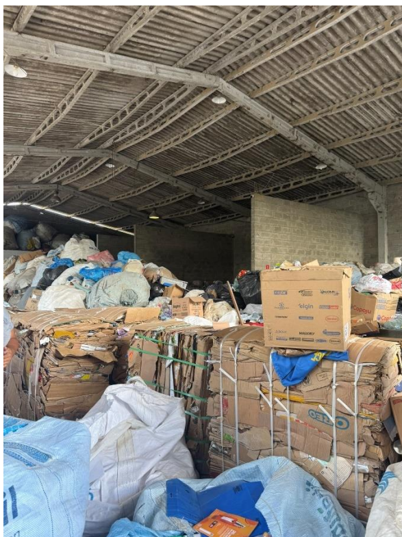
Figura 86 – Galpão de Triagem
