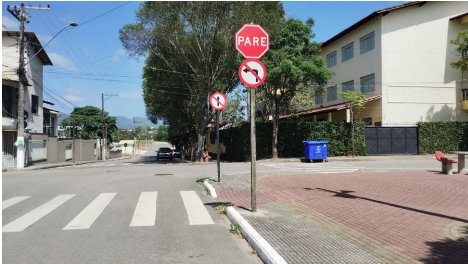
Figura 19: Rua Flor do Estudante: cruzamento com sinalização horizontal e vertical Fonte: Regini, Marcelo. Novembro, 2025.
