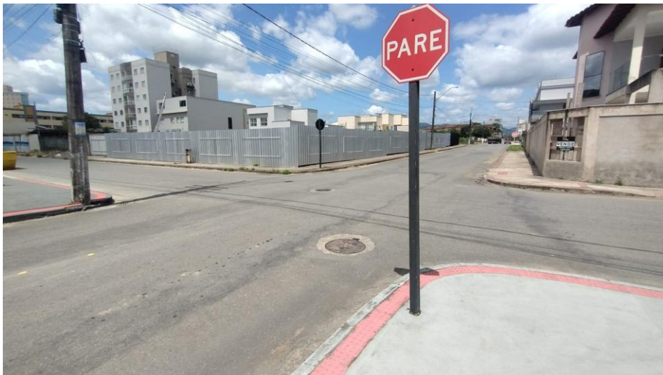
Figura 96: Cruzamento entre a Rua Flor de Noiva e a Rua Leopoldo B. Rangel: ausência de faixa de travessia de pedestres Fonte: Regini, Marcelo. Novembro, 2025.
