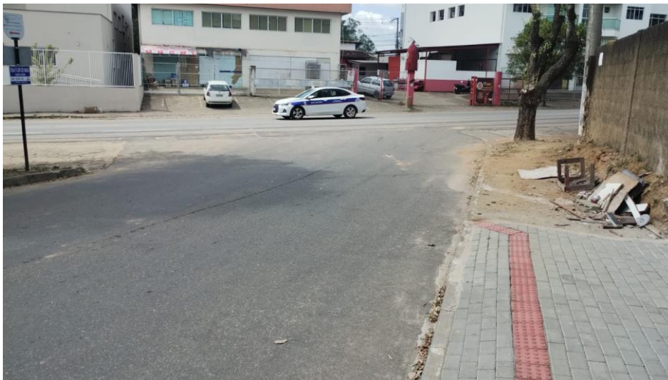
Figura 90: ES-257, esquina com a Rua Flor de Maio: calçadas sem continuidade e ausência de faixas de travessia de pedestres Fonte: Regini, Marcelo. Novembro, 2025.
