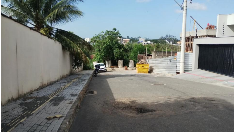
Figura 34: Rua Flor da Criança: lado norte sem saída, calçada irregular à direita. Fonte: Regini, Marcelo. Novembro, 2025.
