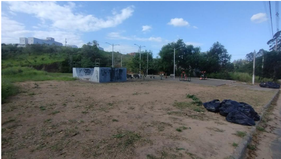
Figura 68: Rua Flor de Maio: praça em necessidade de manutenção. Fonte: Regini, Marcelo. Novembro, 2025
