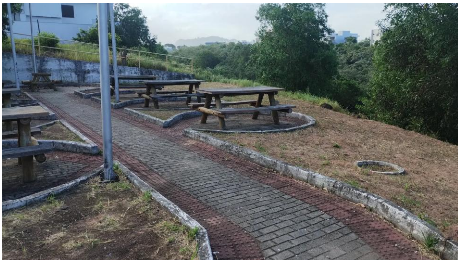
Figura 67: Rua Flor da Amizade: praça em necessidade de manutenção. Fonte: Regini, Marcelo. Novembro, 2025.
