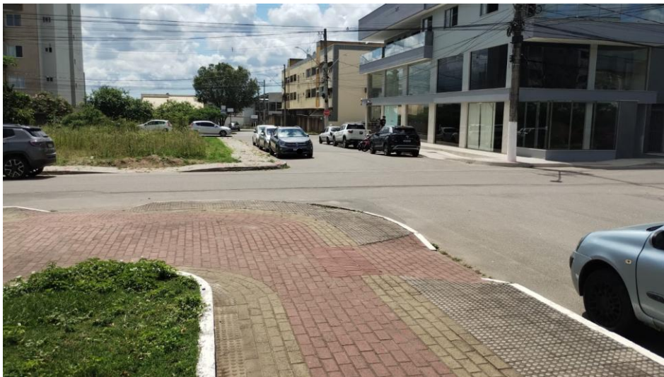
Figura 94: Cruzamento entre a rua Flor do Estudante e a rua Flor de Lotus: calçadas irregulares e sem continuidade. Ausência de faixa de travessia de pedestres Fonte: Regini, Marcelo. Novembro, 2025.
