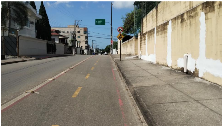
Figura 43: Rua Flor da Imperatriz: ciclovia, sinalização horizontal e vertical. Fonte: Regini, Marcelo. Novembro, 2025.
