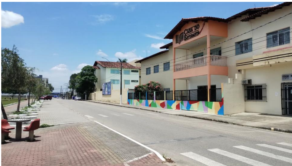
Figura 49: Rua Flor de Liz: área escolar e praça com demarcação horizontal de vagas de estacionamento em via pública.
