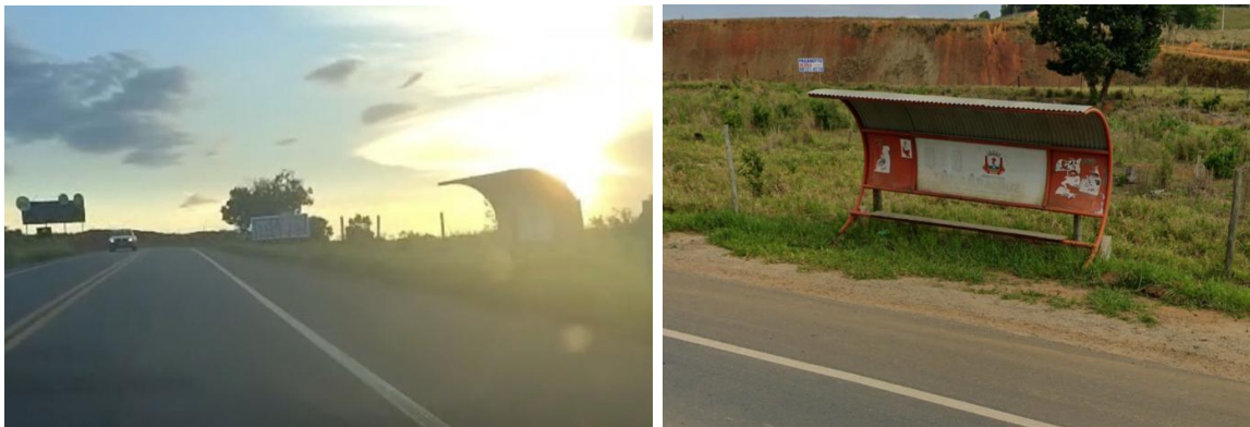
Figura 25: Ponto de parada de ônibus – Sentido Prefeitura – Observa-se falta de pavimento da calçada. Fonte: Autor: Março 2026
